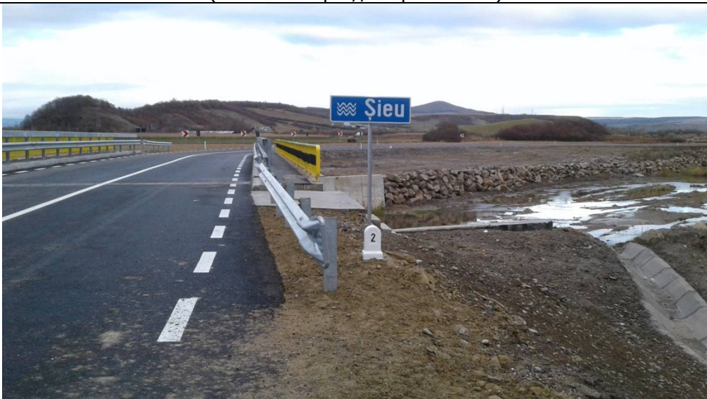
Photo by Claudiu Gavrioloaie Figure 3. The bridge over the Șieu River.
